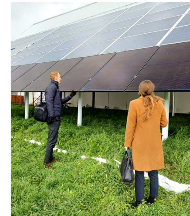
Monitorovacia cesta Moldavsko 2025: centrálny agropotravinársky HUB - inštalácia solárnych panelov
